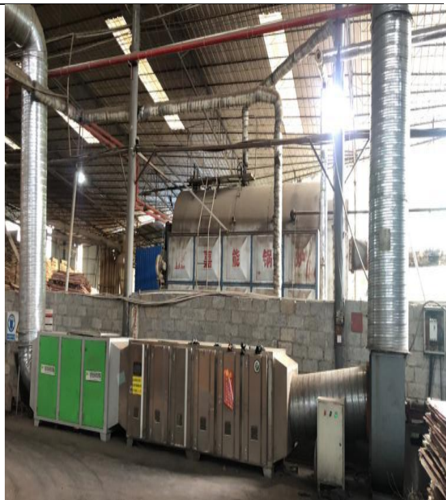
涂胶、热压、喷面油工序监测口、处理设施
